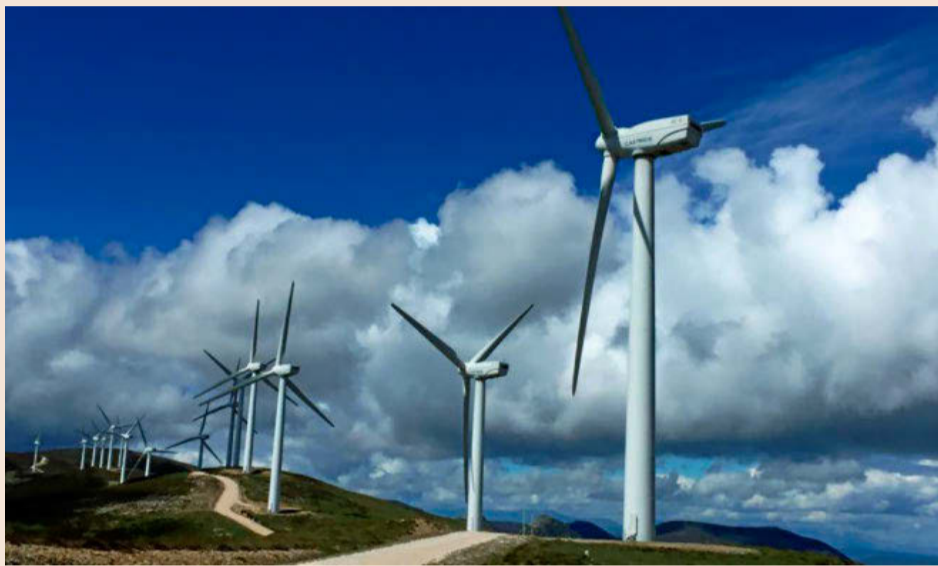
El parque eólico cuenta con 24 aerogeneradores.
