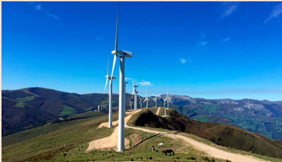
Parque eólico de Cañoneras (Cantabria).
