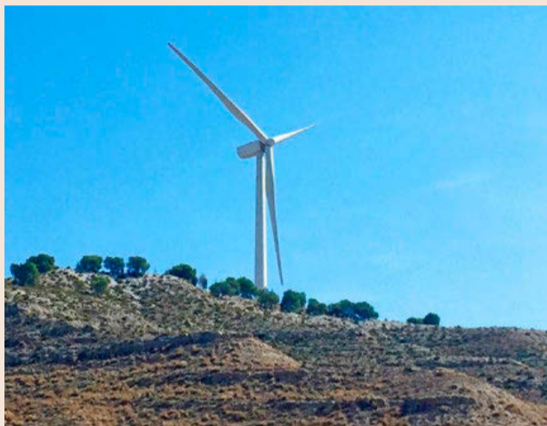
Las instalaciones se encuentran en el término municipal de Cadrete.
