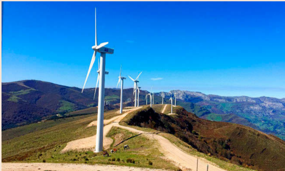
El parque eólico de Cañoneras es el único de este tipo en Cantabria y tiene 38 aerogeneradores.
