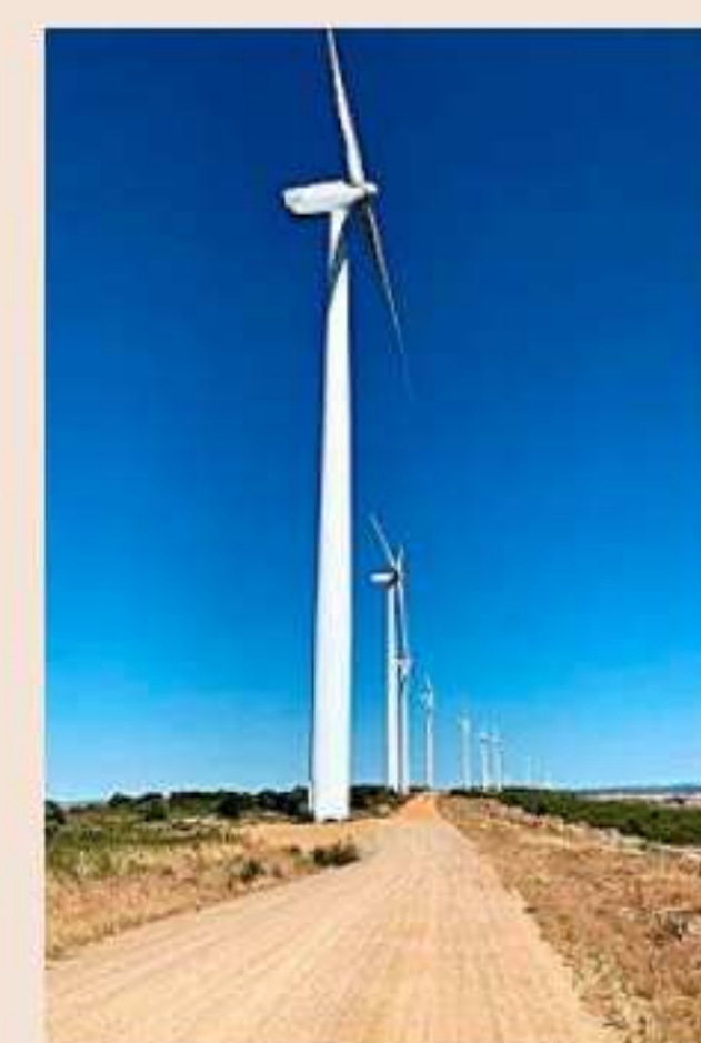
Los tres parques suman una potencia instalada de 80 MW.
