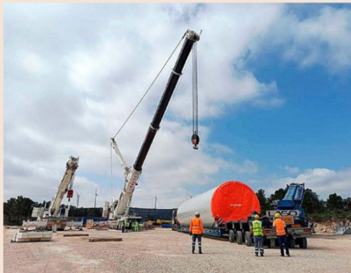
Obras de instalación de nuevas turbinas en el parque eólico de Colladetes, en El Perelló (Baix Ebre).
